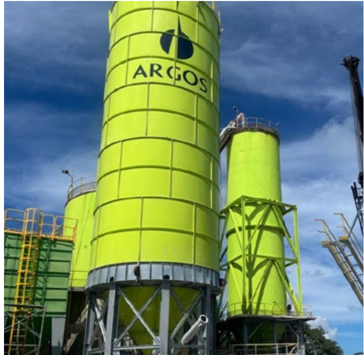
↑ Silo de cemento en Antigua
