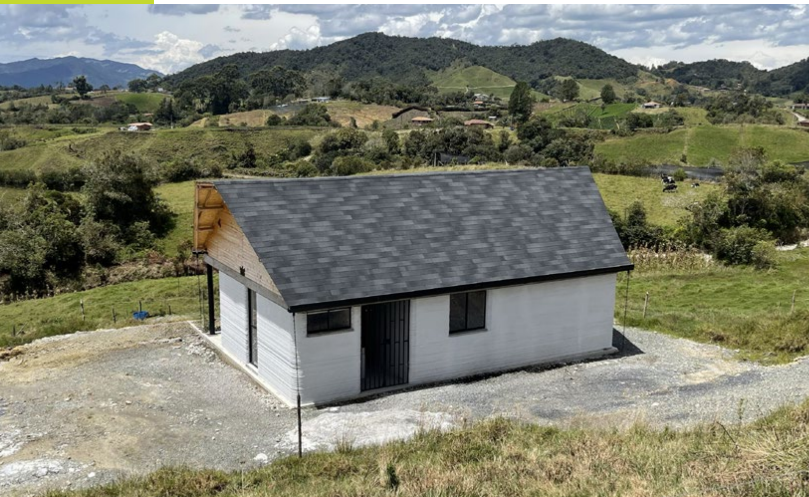
↑ Casa impresa con tecnología 3D en La Unión, Antioquia
