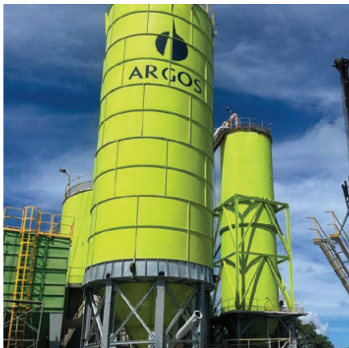
↑ Silo de cemento en Antigua
