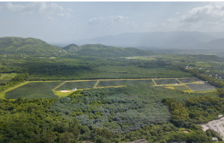
↑ Parque solar Comayagua, Honduras
