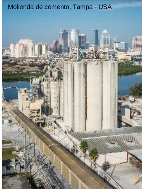
Molienda de cemento
