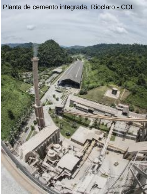
Planta de cemento integrada
