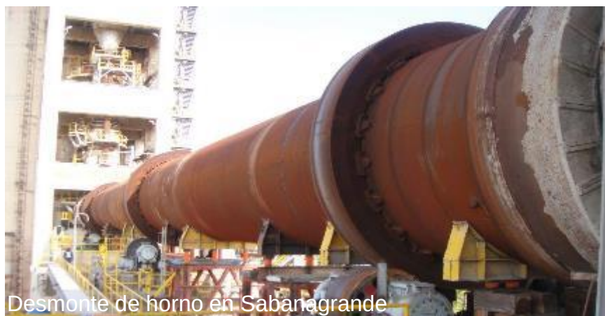
Desmonte de horno en Sabanagrande
