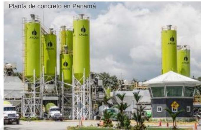
Planta de concreto en Panamá
